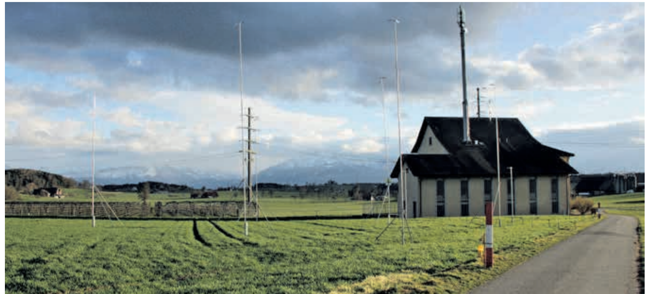
Hier soll eine neue Unterstation der CKW entstehen. Die alte Station (im Hintergrund) wird danach abgerissen. Foto jh
