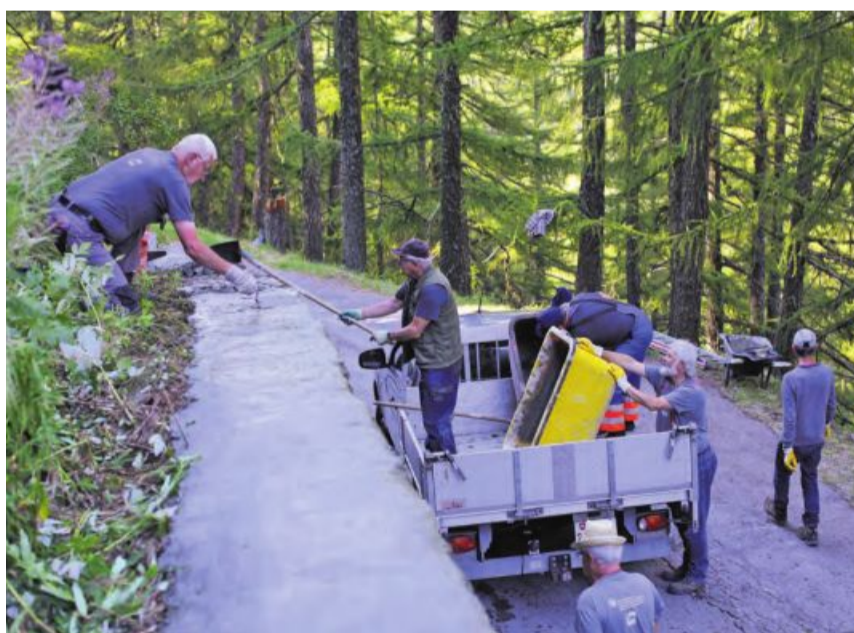
Walter Haas (l.) und Klaus Widmer arbeiten an einer Mauerkrone. Foto pd
